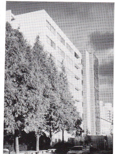
増築工事中の研究科棟
